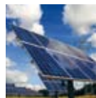
Dachanlagen, Fassadenanlagen und Freiflächenanlagen sind die gebräuchlichsten Anlageformen.
